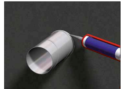
Tätning runt genomföring
